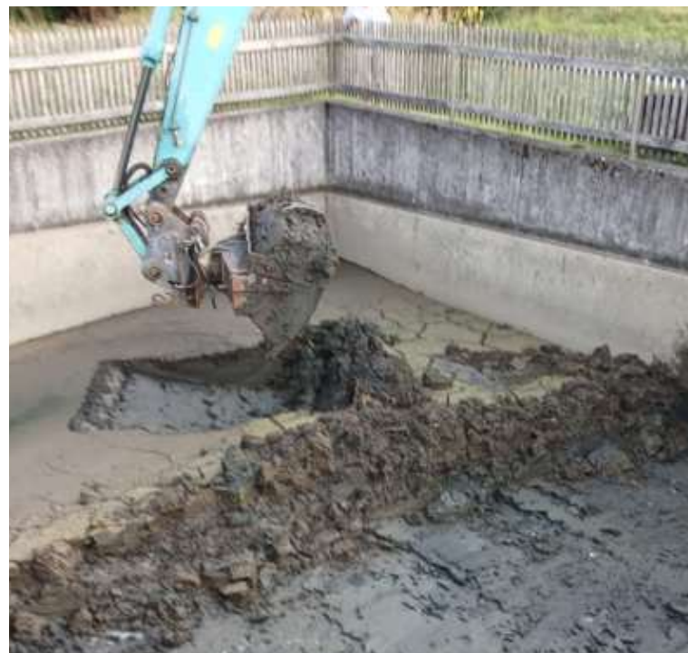
Säuberungs- und Baggerarbeiten im Löschbecken Nondorf
