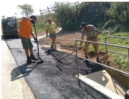
Wasser nur zum Teil aufgenommen. Zur Verbesserung dieser Situation wurde der Weg mit einem Gefälle zur Böschung hin um 1m verbreitert. Den Abschluss bildet ein Asphaltwulst. Damit ist jetzt die Wasserführung fixiert. Mehrere Einlaufschächte nehmen dort das Regenwasser auf. Aufgrund des großen Einzugsgebietes wird bei heftigen Gewittern auch weiterhin Wasser über die Straße abfließen.
