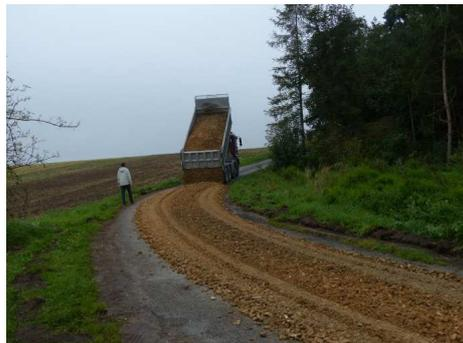
schnitt neben dem Wald 20 cm Schotter aufgebracht. Dieser ist dann zur Verstärkung der Trag-schicht mit dem alten Asphaltbelag eingefräßt worden. Anschließend ist mit einem Grader ein Planum hergestellt und das Ganze mit einer Walze verdichtet worden. Eine 8cm starke Asphaltdecke bildet den Abschluss.
