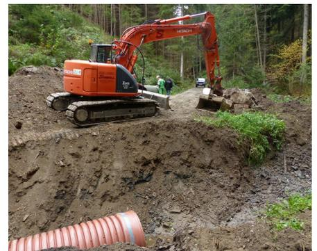
Ein Rohrdurchlass war so stark beschädigt, dass er erneuert werden musste. Hier kam ein Kunststoffschwerlastrohr mit einem Durchmesser von 1m zum Einsatz. Ein weiterer konnte wieder instand gesetzt werden. Der Gesamtschaden beläuft sich auf etwa € 30.000,- und wird je zu einem Drittel von Bund, Land und Gemeinde getragen.
