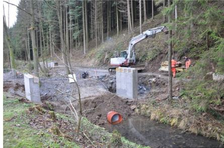
lag bilden, aufgelegt. Die Brücke hat eine Spannweite von 8 m und eine Nutzbreite von 2,5 m. Die Ausschreibung für die Schotterung des Weges von Nondorf bis zur Brücke hat die Firma Hengl gewonnen. Die Grobschotterung ist schon erfolgt. Im Frühjahr wird noch eine Schicht Grader-Material aufgebracht.
