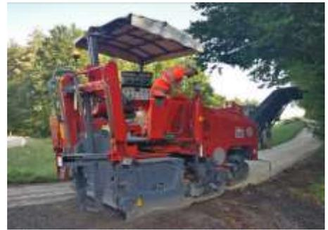
In der KG Altpölla ist von der Firma Langthaler ein Erdweg ausgekoffert und mit tragfähigem Steinmaterial geschüttet worden.
